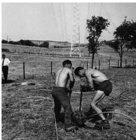
Bau der Leitung Heisdorf-Itzig (Mitte der 1960er-Jahre)
