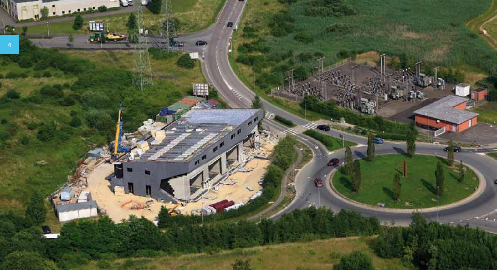
Bau der neuen Innenraumschaltanlage in Ehlingen (rechts: Bisherige Freiluftschaltanlage).
