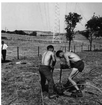
Construction de la ligne Heisdorf-Itzig (milieu des années 60)
